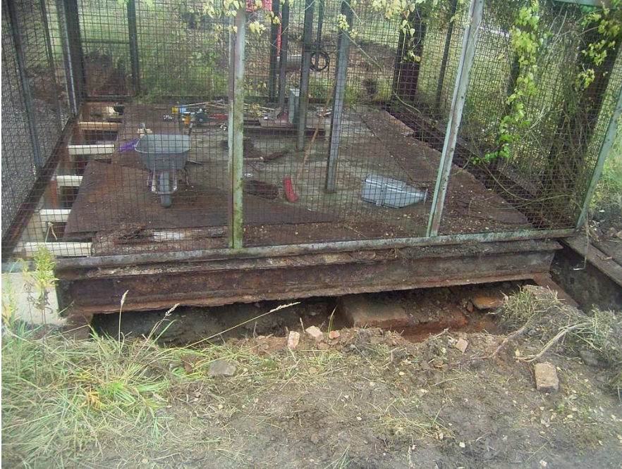
Abbildung 9: Blick auf einen der Hauptträger der freigelegten westlichen Seite der Schachtabdeckung von Schacht Asse 1 (Blickrichtung W-O)
