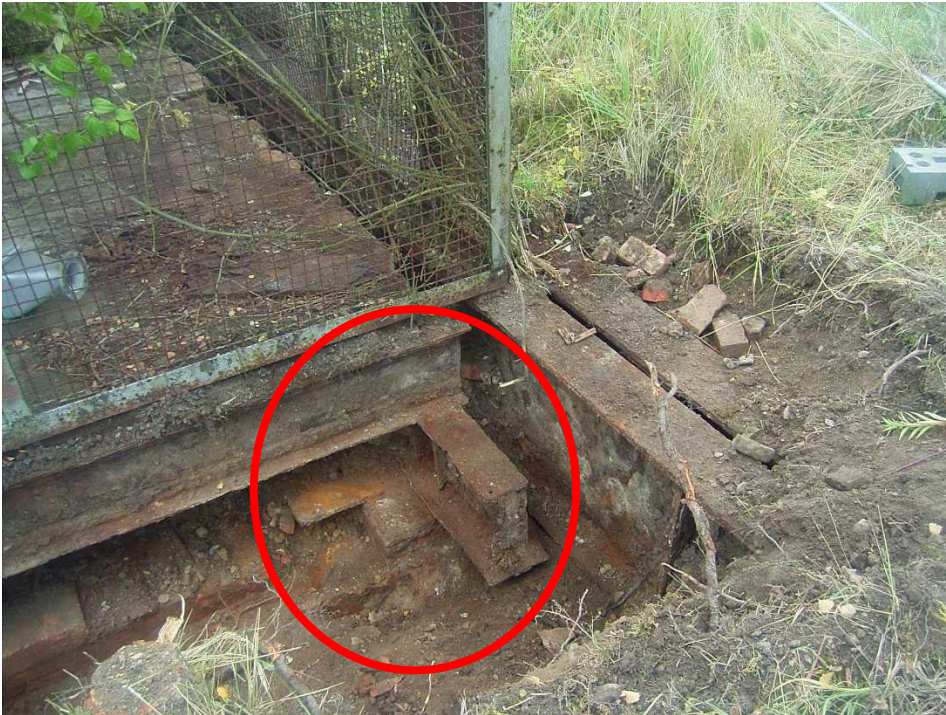
Abbildung 11: Blick auf das süd-westl. Auflager (Mauerwerksstreifen), Endträger und Hauptträger der Schachtabdeckung Schacht Asse 1
