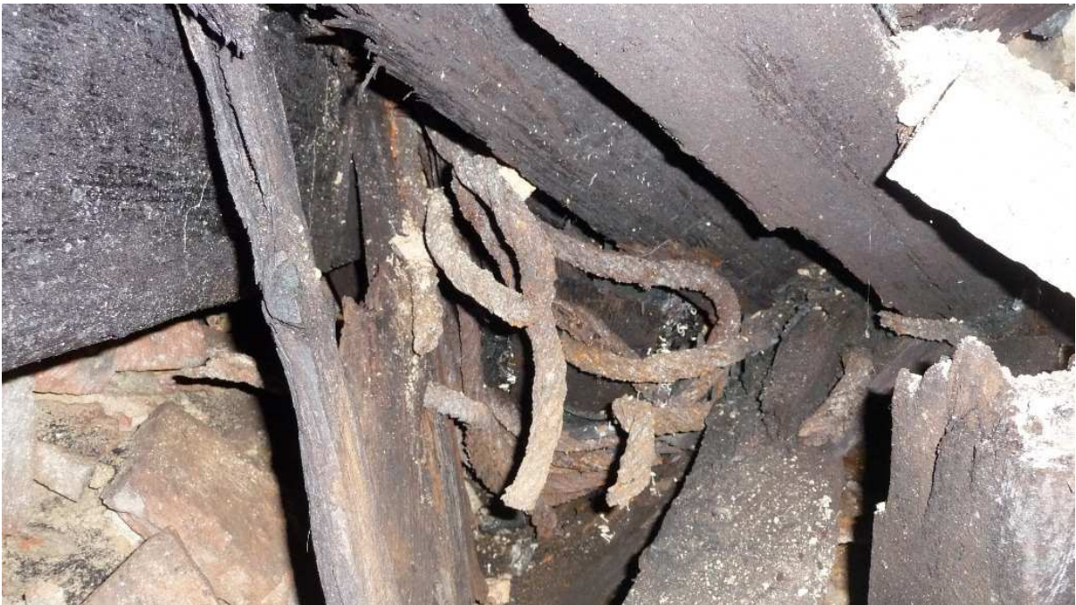
Abbildung 28: Blick in den südlichen Hohlraum (Pos.1 ) mit Holz- und Seilresten (Blickrichtung N-S)
