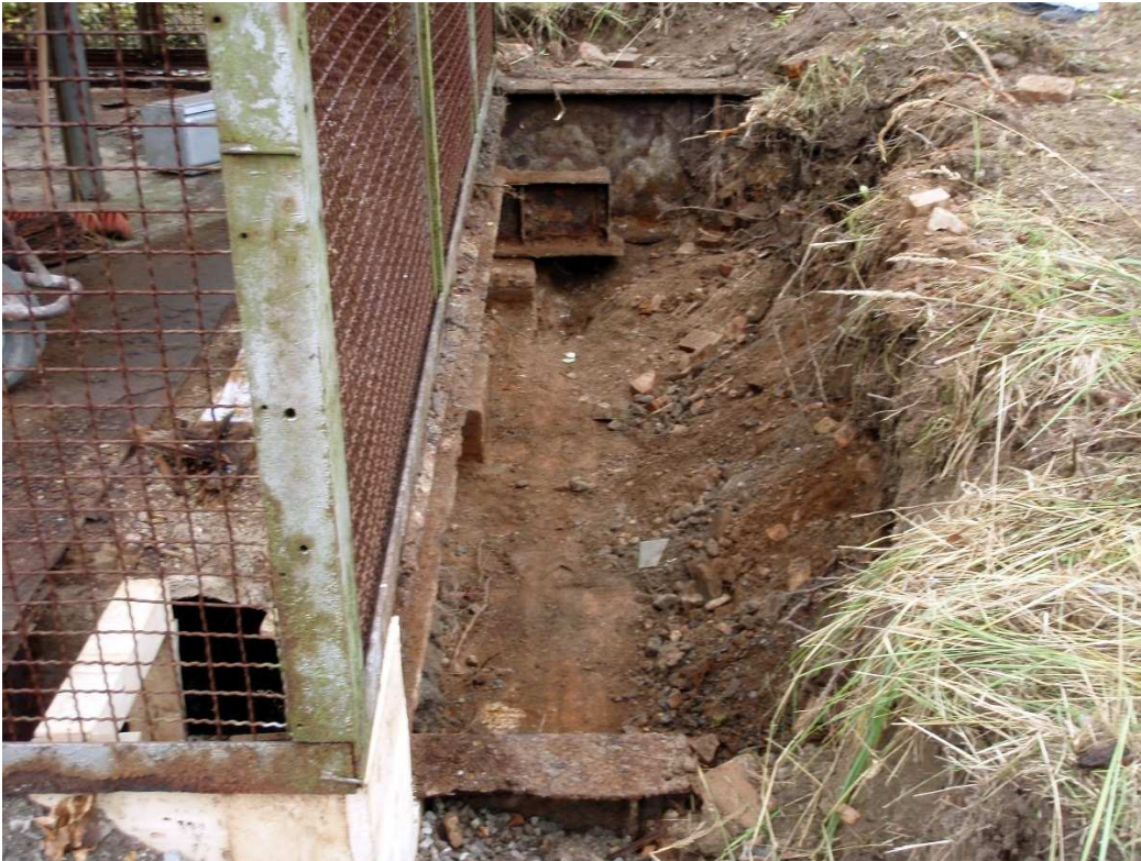
Abbildung 8: Freigelegter westlicher Bereich von Schacht Asse 1 (Blickrichtung N-S) mit Blick auf den nördl. und südlichen Endträger sowie das südliche Auflager der Endträger der Schachtabdeckung
