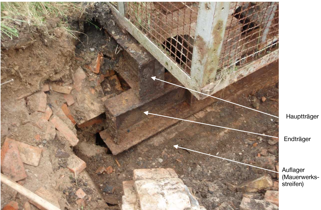
Abbildung 5: Blick auf die Hauptträger, Endträger sowie das Auflager für die Endträger (Mauerwerksstreifen) der Schachtabdeckung (Blickrichtung NO-SW)
