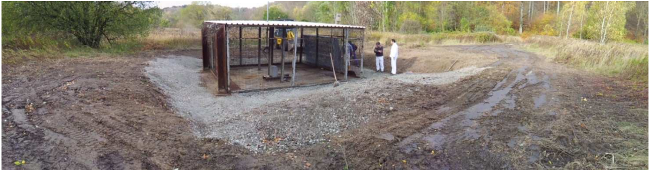
Abbildung 23: Panoramaaufnahme von Schacht Asse 1 nach Abschluss der Arbeiten (Blickrichtung SO-NW)
