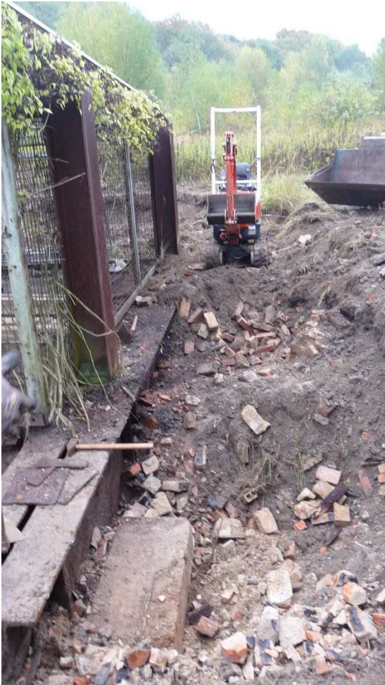
Abbildung 13: Blick auf den südlichen Bereich von Schacht Asse 1 der mittels Minibagger freigelegt wird (Blickrichtung W-O)
