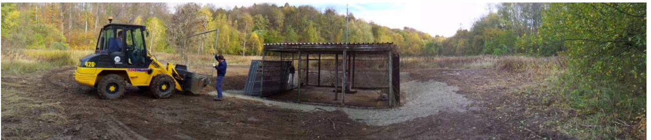
Abbildung 24: Panoramaaufnahme von Schacht Asse 1 nach Abschluss der Arbeiten (Blickrichtung W-O)
