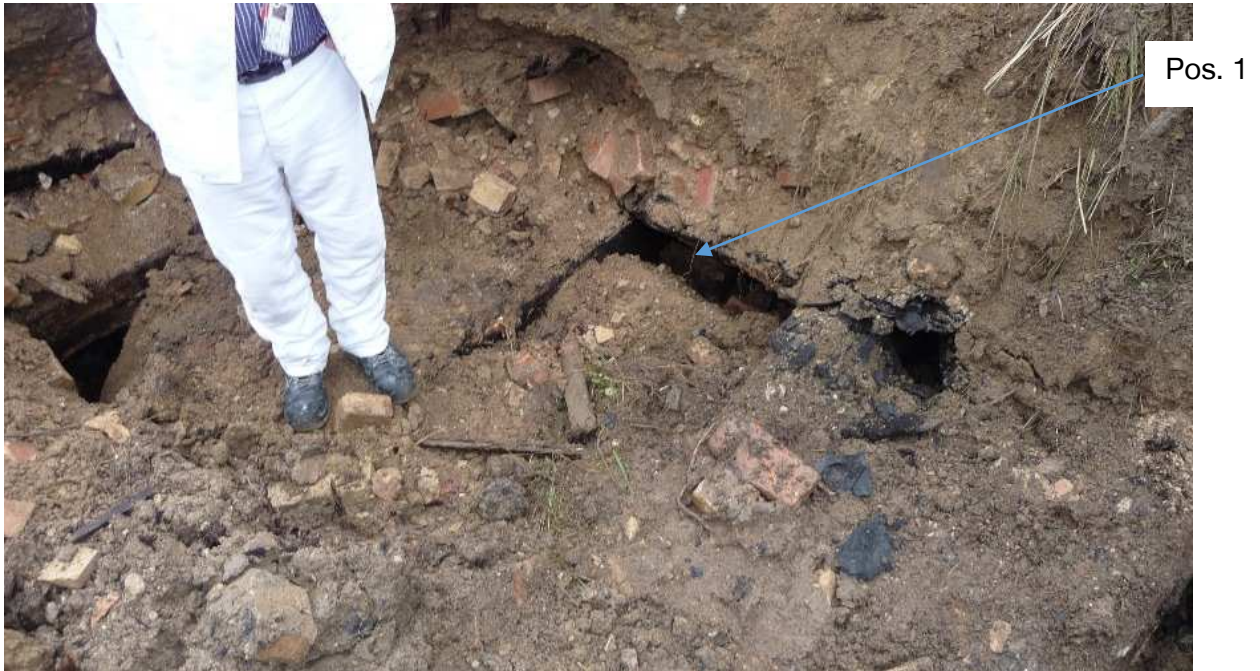
Abbildung 27: Blick auf den freigelegten Hohlraum (Pos. 1) im südlichen Bereich von Schacht Asse 1
