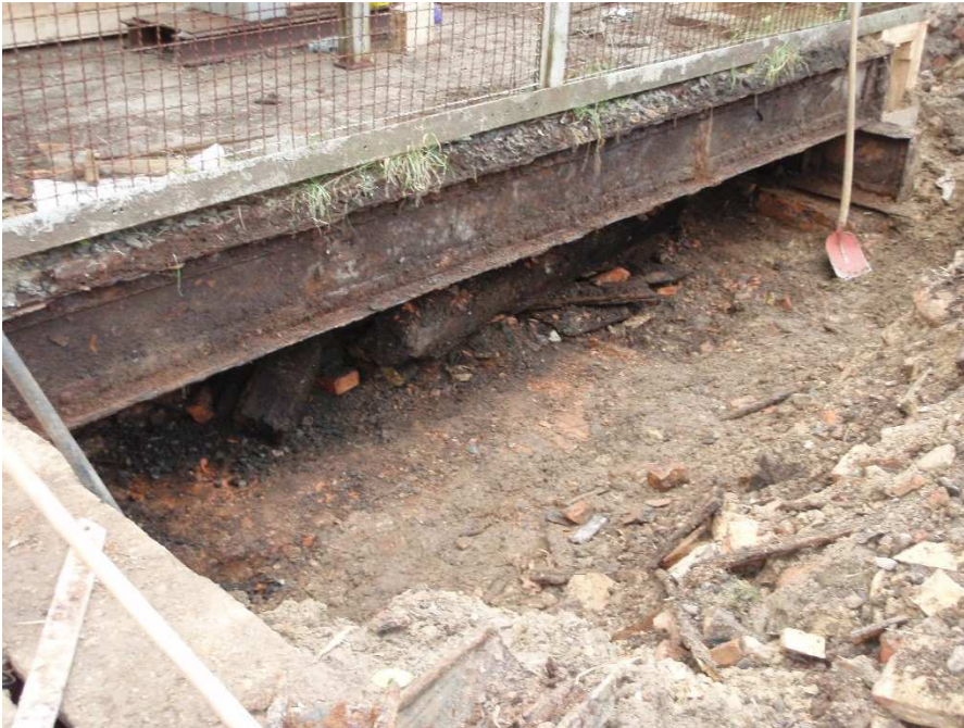
Abbildung 17: Blick auf den freigelegten äußersten Hauptträger der Schachtabdeckung im östlichen Bereich von Schacht Asse 1 (Blickrichtung SO-NW)
