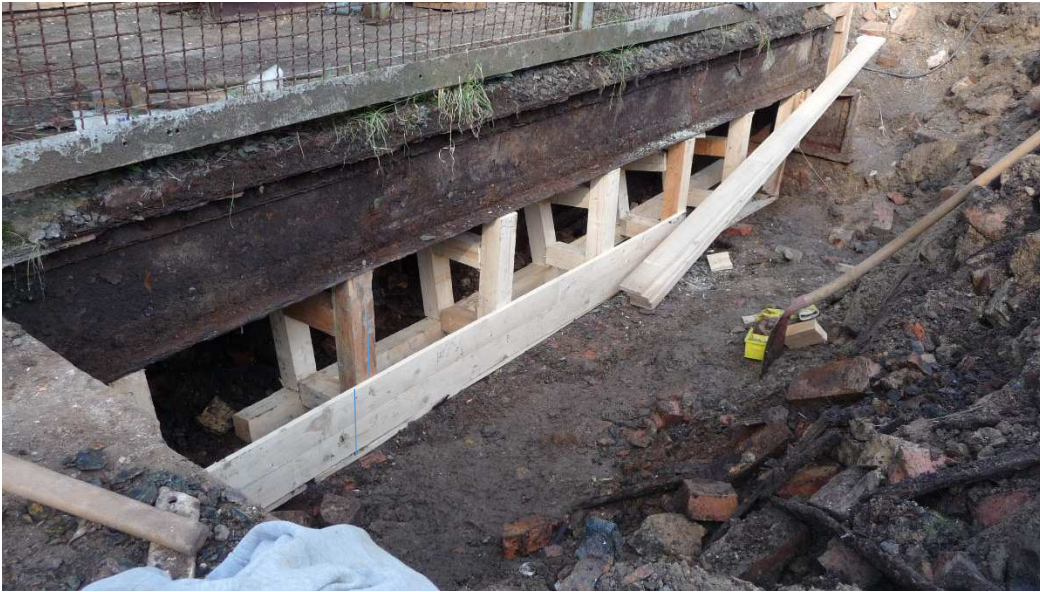
Abbildung 21: Blick auf die Verschalungskonstruktion unterhalb der östlichen Schachtabdeckung
