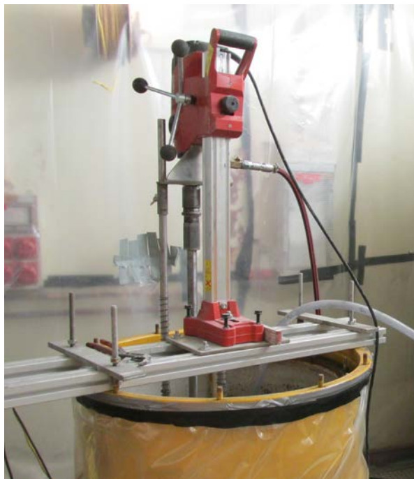
Abb. 6 Aufbau zum Trockenbohren in die radioaktiv dotierten Probekörper in der Zelle der HDB. Rechts: Schlauch zum Absaugen des Bohrstaubs.
