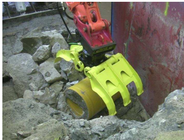
Abbildung 84: Eingesetzter Nukleargreifer des Herstellers Kinshofer GmbH.
