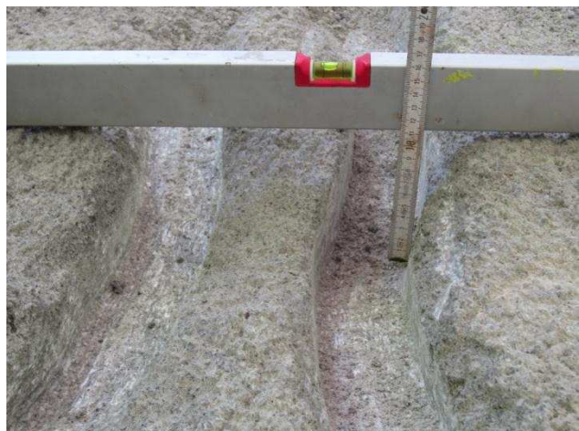
Abbildung 38: Reißzahn - Schürftiefe von ca. 11 cm im Steinsalzbeton.
