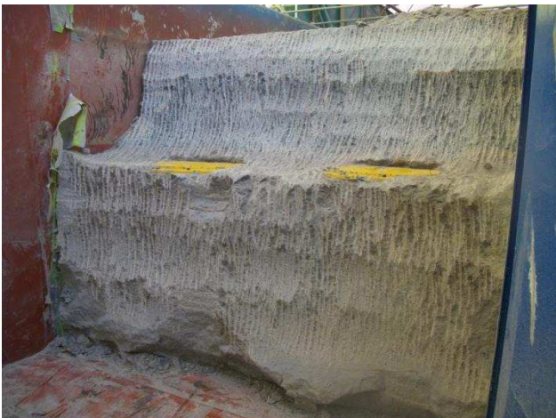
Abbildung 49: Seitenansicht der teilweise durch das Fräsen freigelegten Gebinde.
