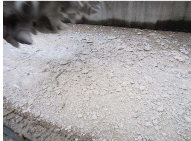
Abbildung 42: Hydraulikfräse – Bruchstücke aus dem Beton.
