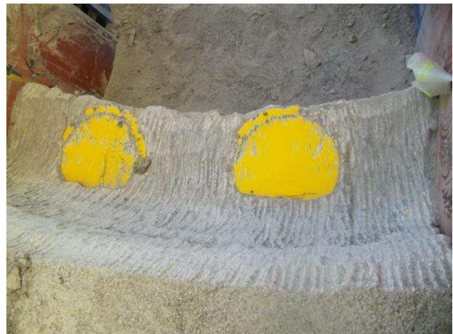
Abbildung 50: Draufsicht auf die teilweise durch das Fräsen freigelegten Gebinde.
