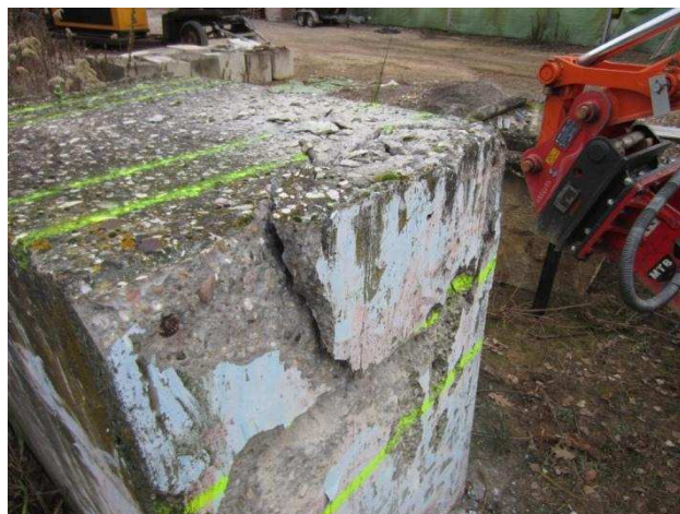
Abbildung 58: Hydraulikmeißel – keilförmig herausgelöstes Betonstück.
