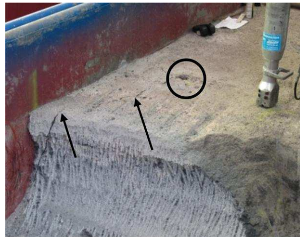
Abbildung 81: Einsatz des Spaltgeräts am Steinsalzbeton sowie erste Rissbildung.
