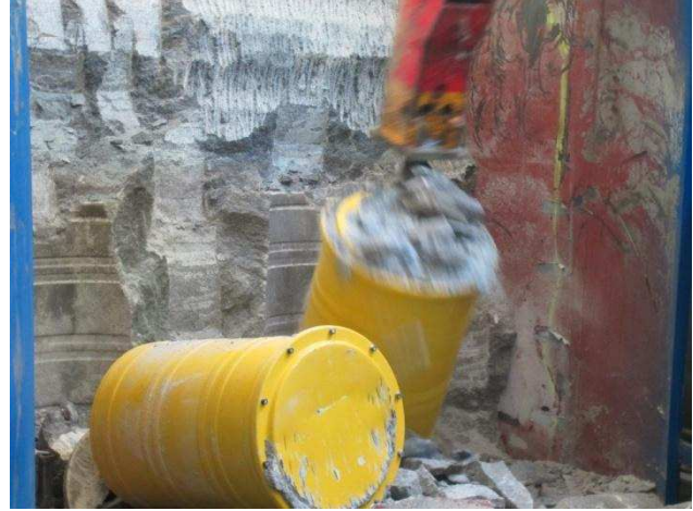
Abbildung 68: Flachmeißel – Herauslösen der Gebinde aus dem Steinsalzbeton.
