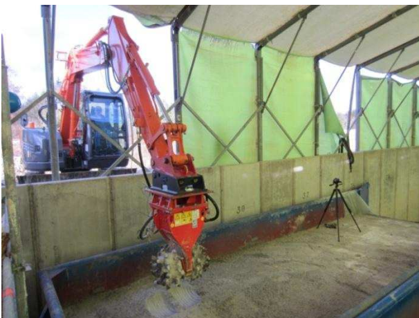
Abbildung 44: Fräsversuche in Steinsalzbeton.
