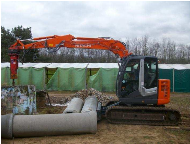
Abbildung 56: Vertikale Meißelposition am Betonblock.
