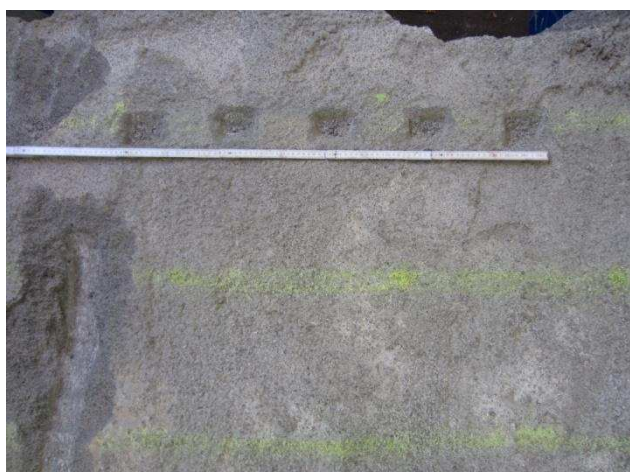
Abbildung 25: Einschlagpunkte der Löffelzähne im Steinsalzbeton beim „Schlagen“.
