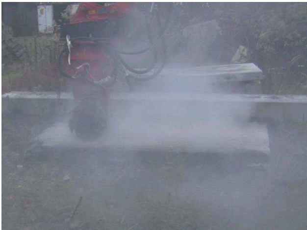
Abbildung 53: Staubentwicklung beim Fräsen in Beton.
