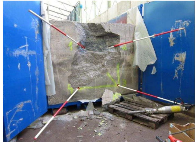
Abbildung 74: Abtragsergebnis des Spaltgeräts nach dem zweiten Spaltvorgang.
