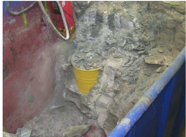
Abbildung 70: Staubentwicklung beim Meißeln in Steinsalzbeton.
