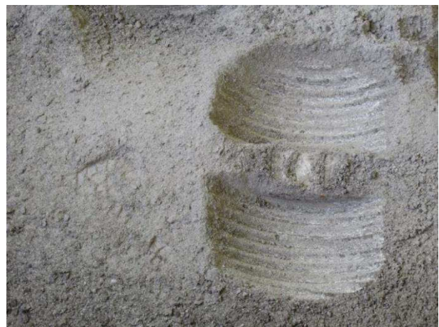
Abbildung 45: Fräsbild in Steinsalzbeton.
