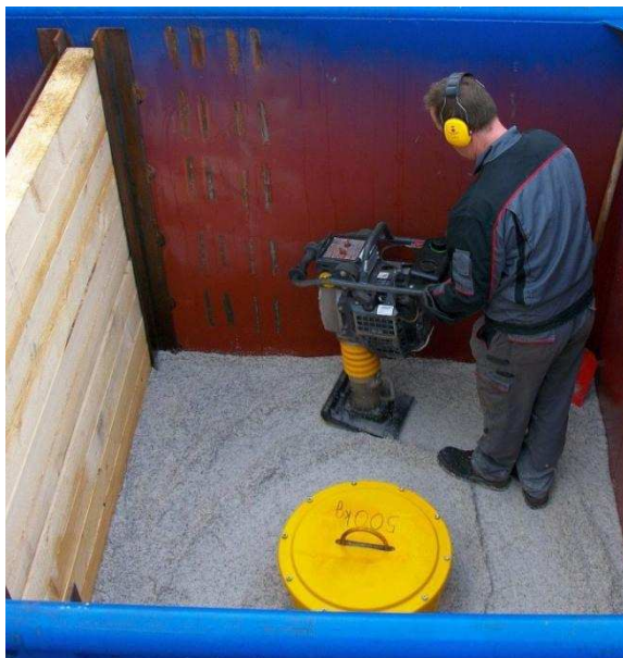
Abbildung 95: Zur Salzverdichtung eingesetzter Vibrationsstampfer.
