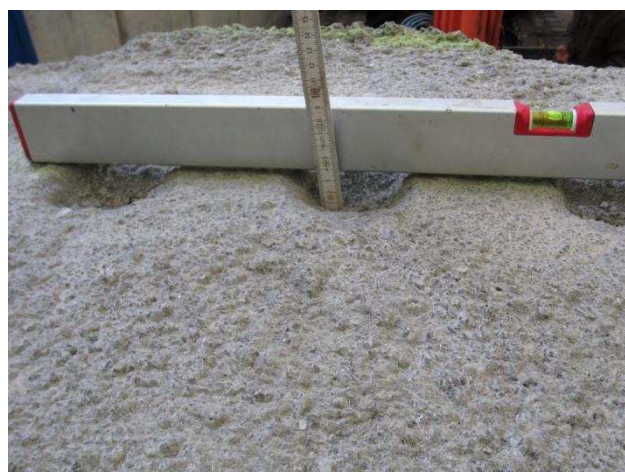
Abbildung 26: Einschlagtiefe der Löffelzähne im Steinsalzbeton beim „Schlagen“.
