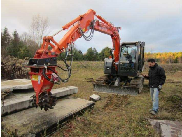
Abbildung 41: Referenzversuche mit der Hydraulikfräse in Beton.
