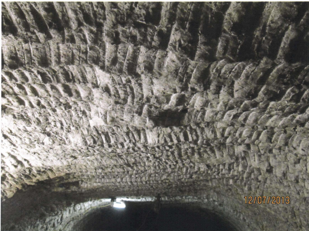
Bild 27: Eingangsbereich Hauptquerschlag n. Norden mit Abschalungen in Firste u. Stoß
