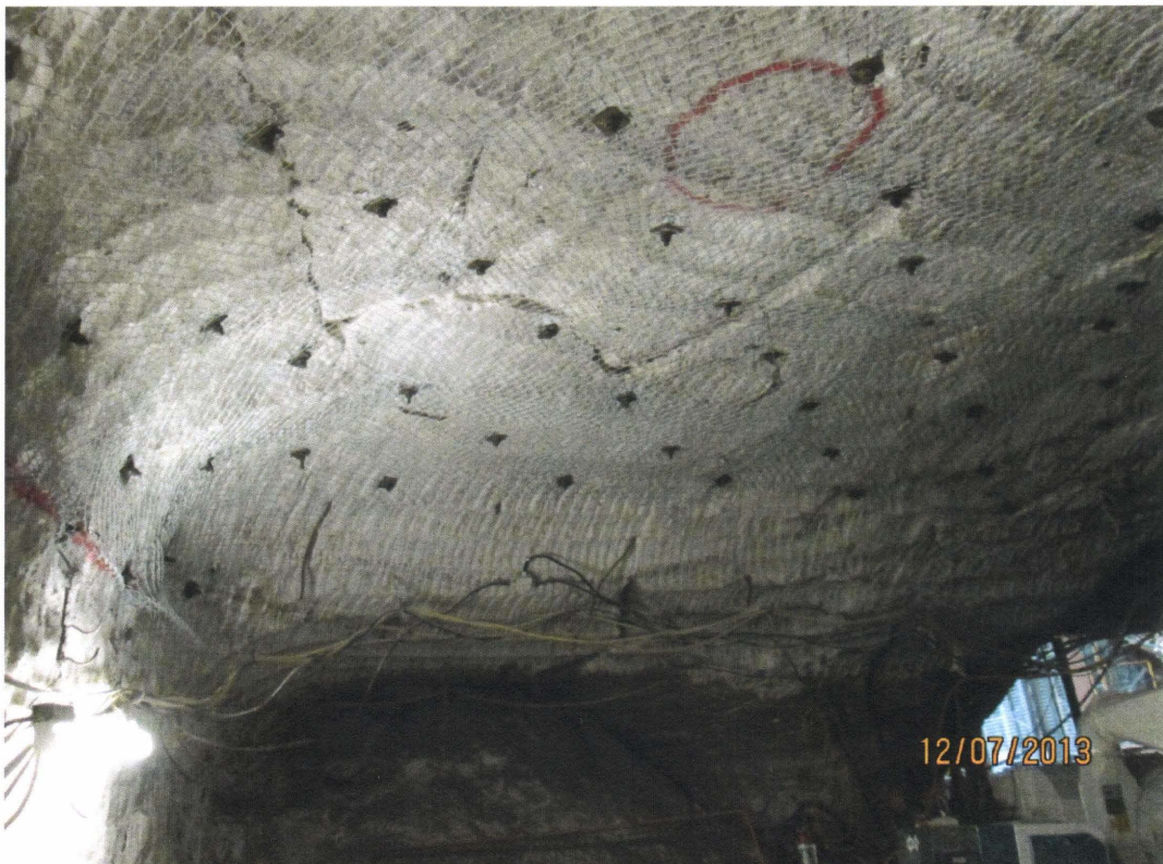
Bild 24: Fortsetzen der Systemankerung nach Berauben kleinräumiger Abschalungen
