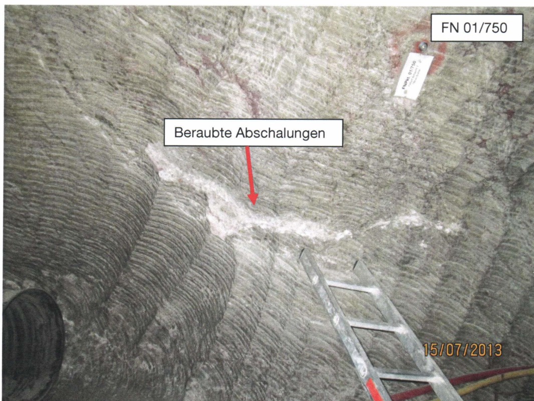
Bild 28: Nördl. Richtstrecke n. West. mit beraubten Abschalungen im Übergang Firste/Stoß
