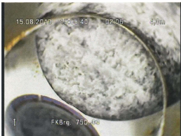
Bild 3: Scherfläche, geschlossen (FKBrG.750-03 -Position ca. 4,10 m)
