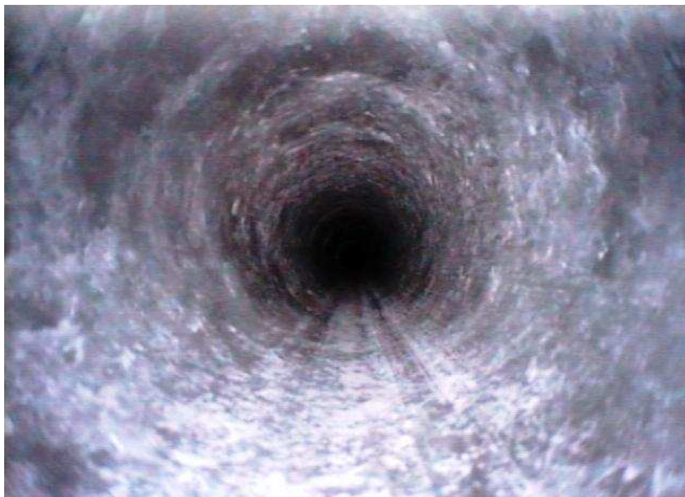
Foto 5a: Bohrloch bei 24,0 m
