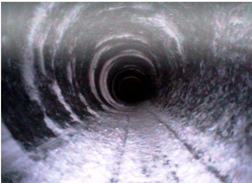
Foto 9d: Bohrloch bei 52,85 m
