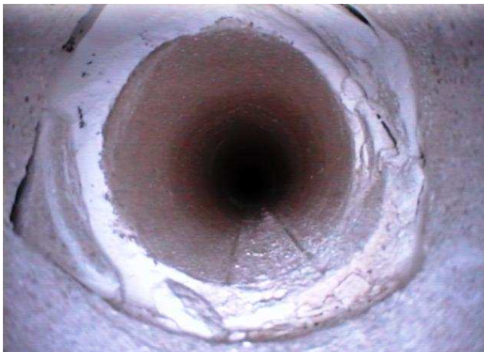
Foto 3i: Kluft bei 44,18 m
