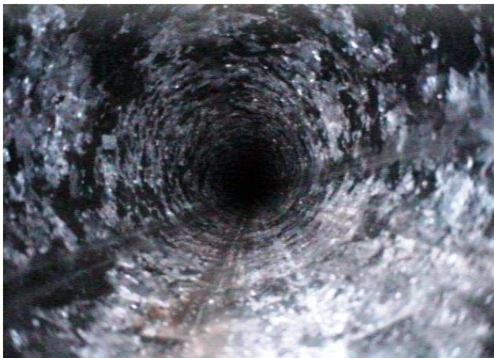
Foto 11e: Bohrloch feucht bei 24,80 m
