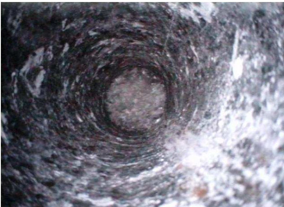
Foto 12f: Bohrlochende bei 61,87 m
