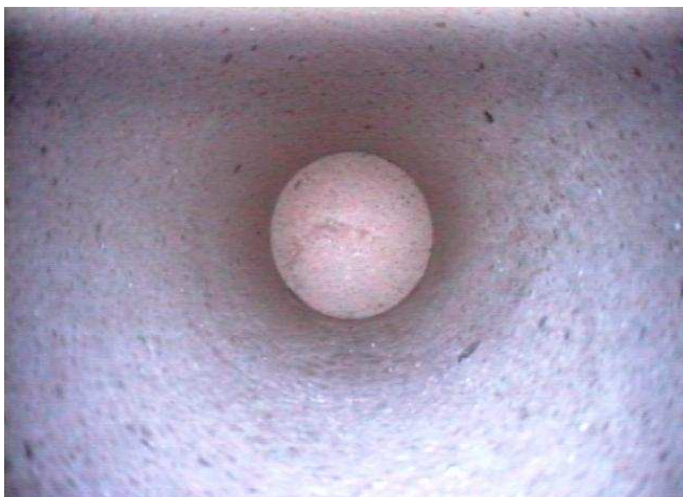
Foto 3j: Bohrlochende bei 47,93 m
