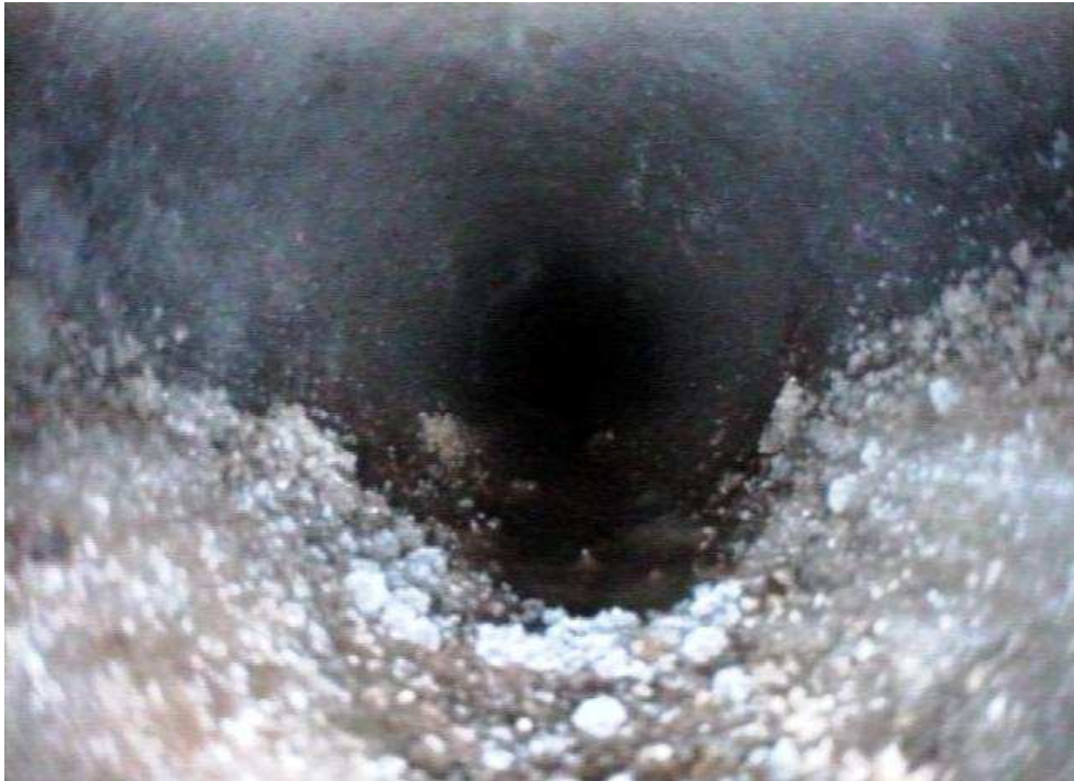
Foto 2a: Bohrloch feucht bei 0,70 m
