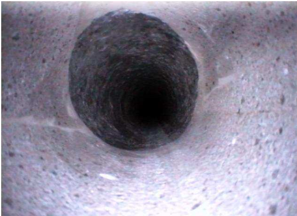
Foto 9c: Übergang Sorelbeton/Steinsalz bei 46,40 m
