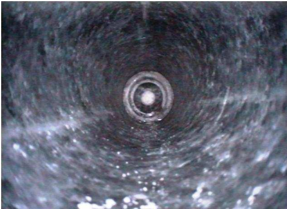
Foto 2e: Bohrlochende bei 57,44 m
