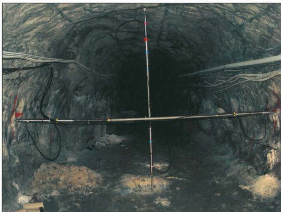
Abbildung 2.7: Beispiel eines Konvergenzkreuzes auf der 750-m-S - Messstelle T1
