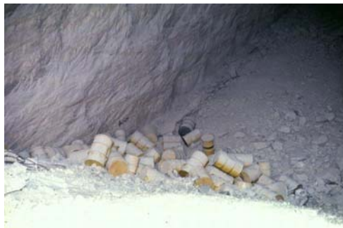
Abb. 5: Kammer mit schwachradioaktiven Abfällen und Salzversatz, Abkipptechnik
