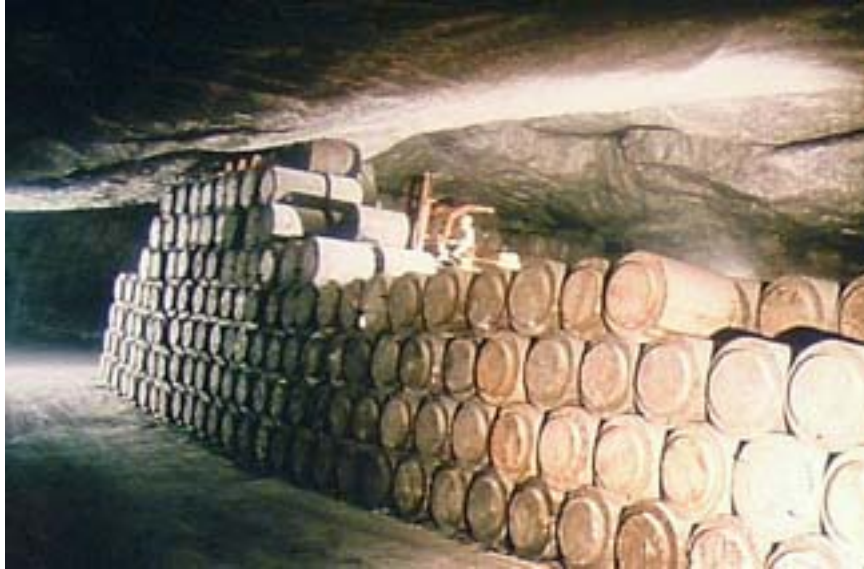
Foto 5: Stapeltechnik, Verlorene Betonab- schirmungen liegend
