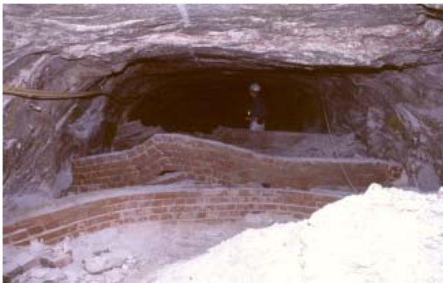
Foto 16: Auswirkungen der Kon- vergenz in einer Strecke
