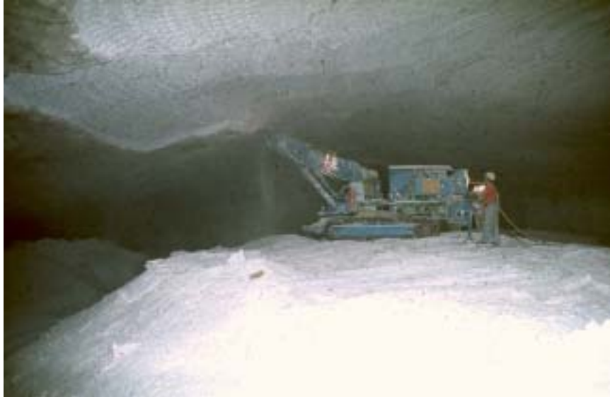
Foto 18: Beraubearbeiten an der Firste mit einer Firstenfräse
