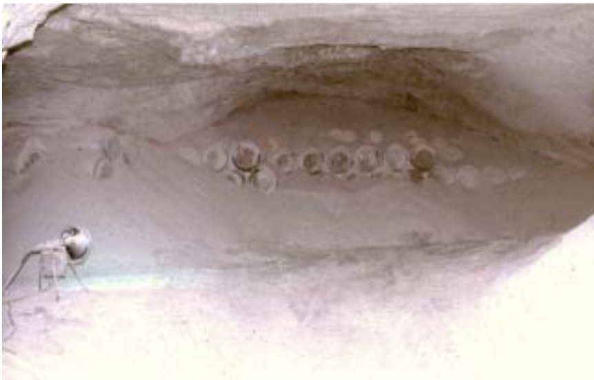
Foto 10: Liegende VBAs, Firstspalt mit Salz verblasen
