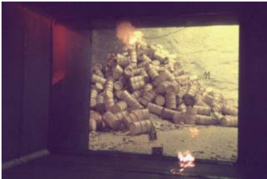
Foto 12: MAW - Einlagerungs- kammer 8a, 511-m-Sohle, Fasskegel
