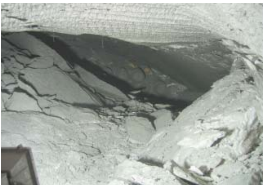
Foto 11: Abbau 5, 750-m-Sohle Liegende VBAs, First- spalt mit Salz verblasen
