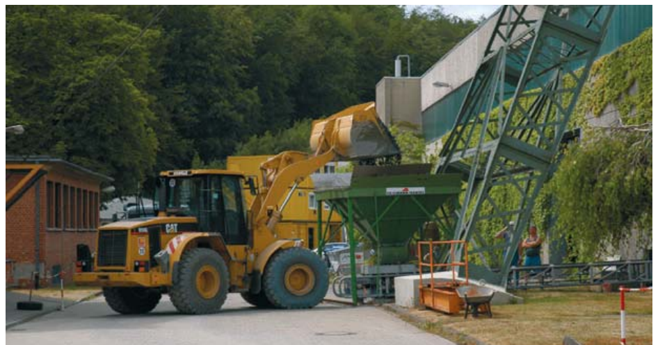
Die Verfüllung der Kaverne am Ende von Schacht 4 beginnt mit dem Einbringen von Schotter in einen Trichter.
