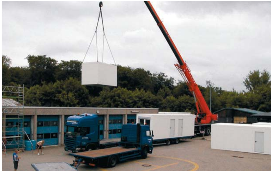
Anlieferung des Laborgebäudes im Juni 2005.
