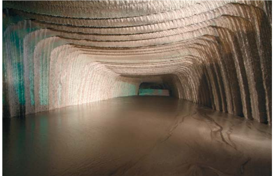
Die ersten 500 Kubikmeter Sorelbeton wurden auf der 750-m-Sohle eingebaut.
