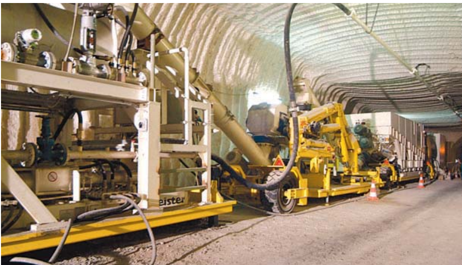
Die mobile Misch- und Pumpenanlage zur Herstellung von Sorelbeton.
