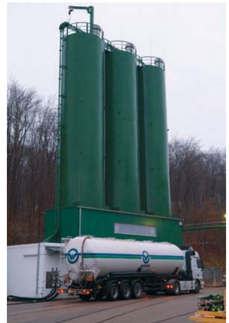
Siloanlage zur Speicherung der Basismaterialien für den Sorelbeton.
