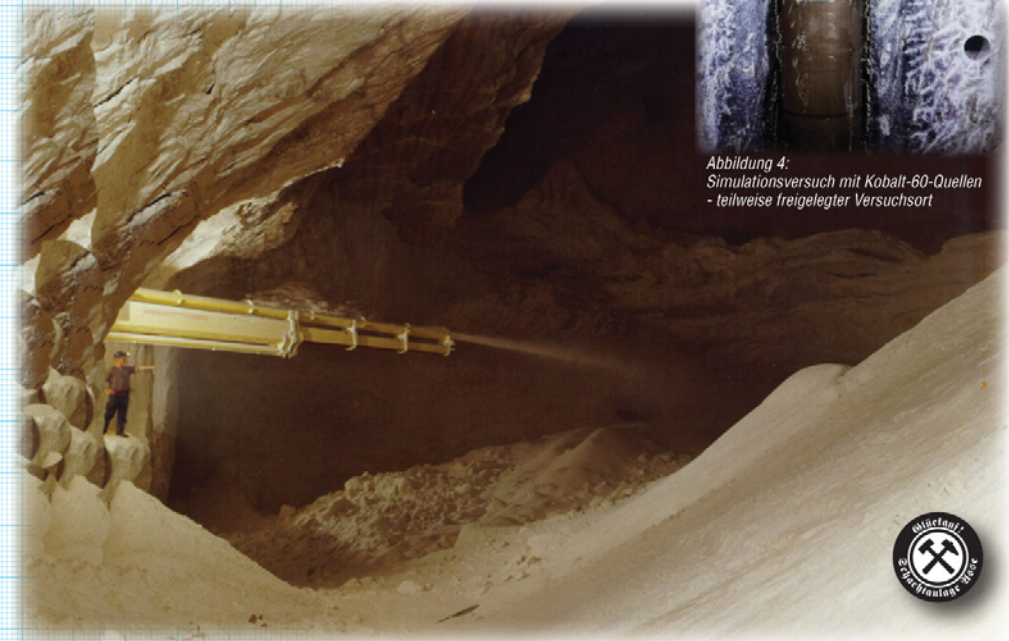
Abbildung 5: Verfüllung der Kammer 8 auf der 637-m-Sohle
