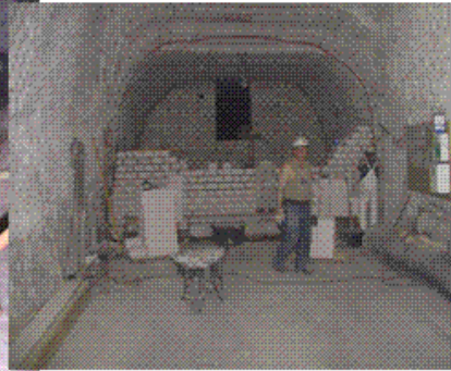
Schalungswände Variante 1: Mauern
