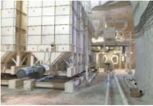
Abb. 1: Die Baustoffanlage auf der 700-m-Sohle ging Ende 2005 in Betrieb.
