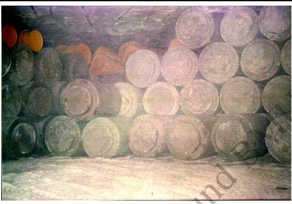
Bild: 9 Einlagerungskammer 11/750 Archiv Nr.: e 217 Gestapelte VBA's und sonstige Gebinde oberhalb der eingebrachten Ausgleichsschicht zwischen den unteren gekippten Fässern und den oberen gestapelten Fässern Aufnahme vom: 27.10.1977
