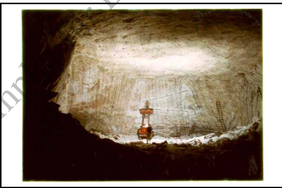
Bild: 10 Einlagerungskammer 1/750 Archiv Nr.: c 116 Berauben des westlichen Stoßes Aufnahme vom: 15.12.1967
